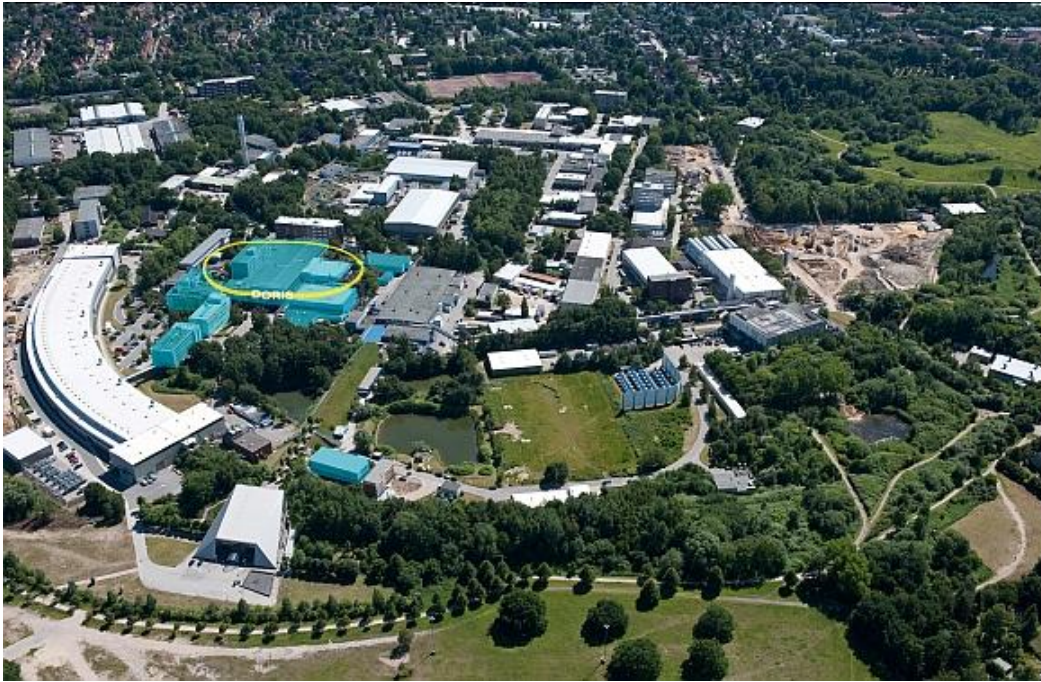
Abbildung 4.1: DESY-Gelände, Vogelperspektive aus nördlicher Richtung. Eingezeichnet ist der Speicherring DORIS III.
